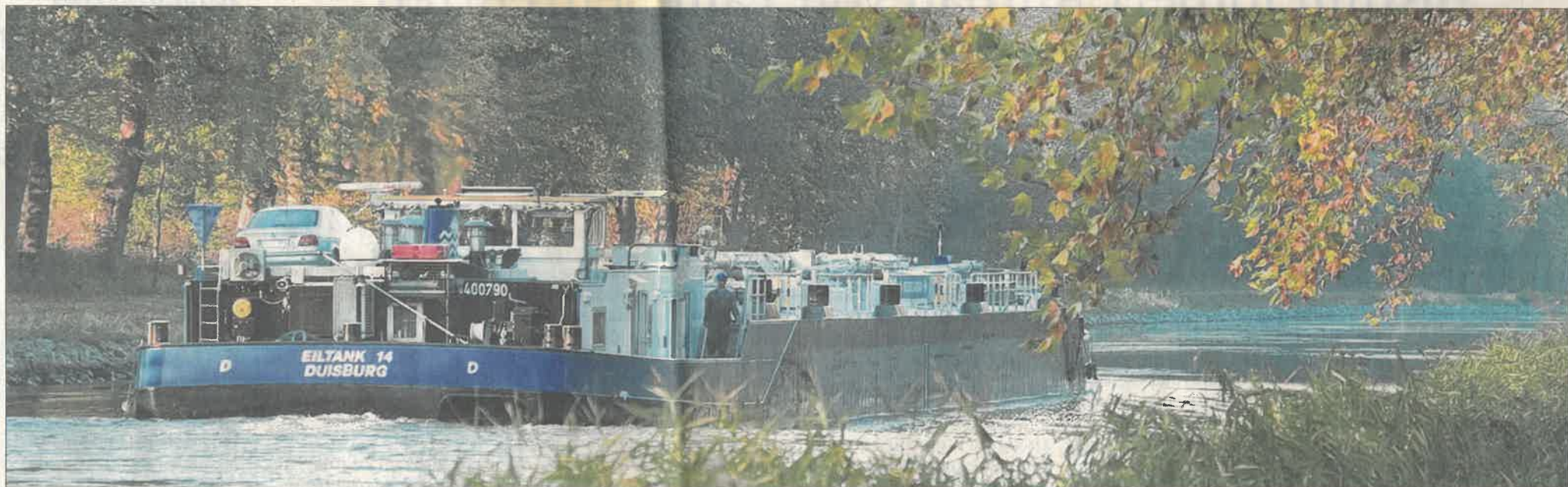
Im Zuge des Ausbaues des Dortmund-Ems-Kanals wird auch der Engpass für Großmotorgüterschiffe im Lingener Stadtgebiet beseitigt.
